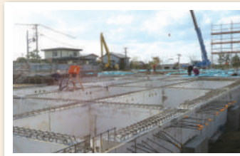
建設工事着工
